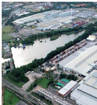
EECの工業団地
