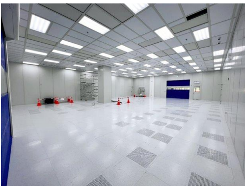
稼働開始当初の製造フロア (現在はフル稼働中)
