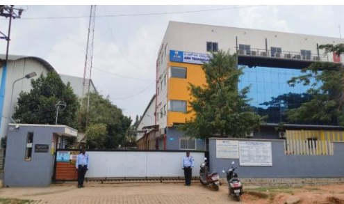
半導体・電子機器向け装置の製造拠点
