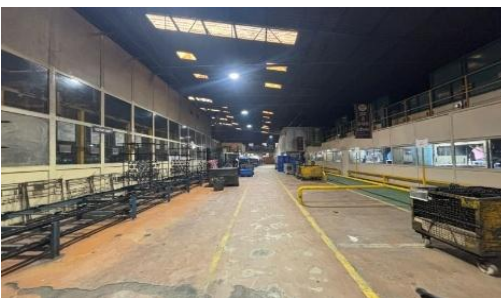
左側にCED塗装、右側に液体塗装 のラインを配置した製造フロア
