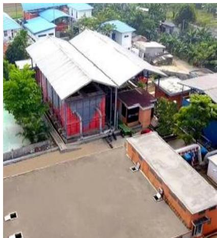
浄化施設全景
