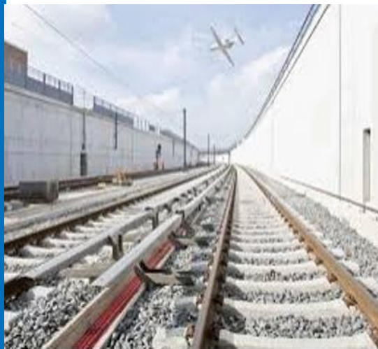
電化高架線路
