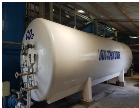
液化酸素の貯槽設備
