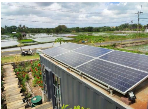
住宅用太陽光発電設備 設置プロジェクト
