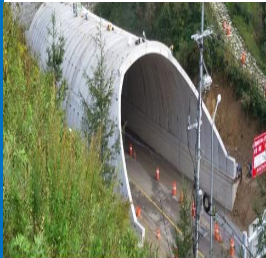
トンネル工事現場
