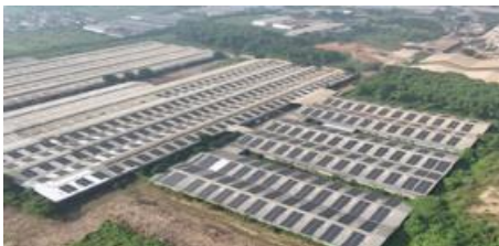
太陽光発電所
