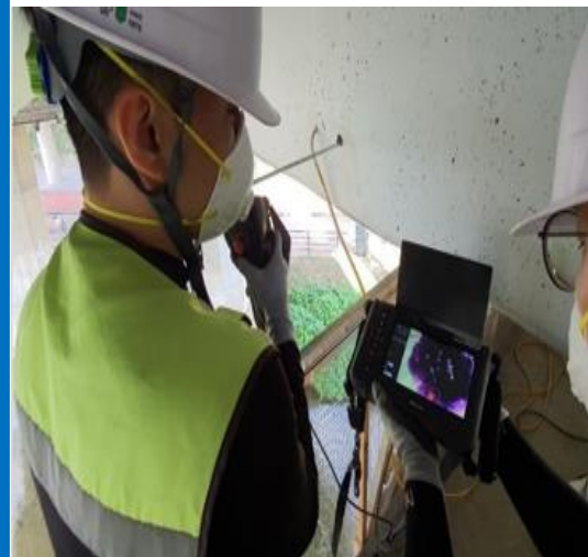
現場作業風景
