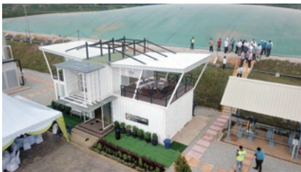
バイオガスプラント (2)
