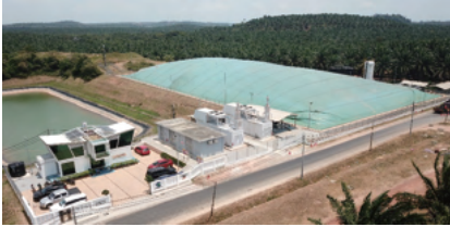
バイオガスプラント (1)
