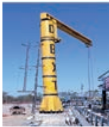
ジブクレーン
