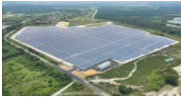
太陽光発電施設(2)
