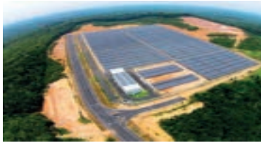
太陽光発電施設(1)
