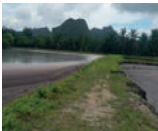
パームオイル工場の排水プール
