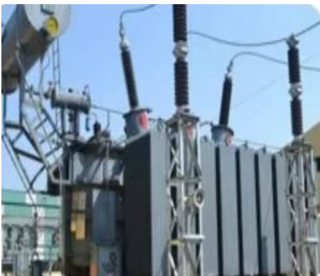
鉄道用、変圧・送電システム
