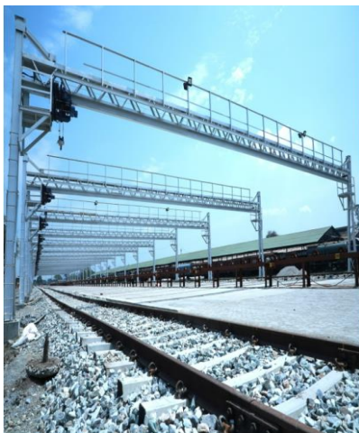
高速鉄道用軌道構築
