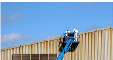
エポキシ樹脂コーティング （床および建物高所）
