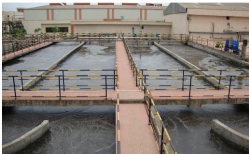
排水処理プラント
