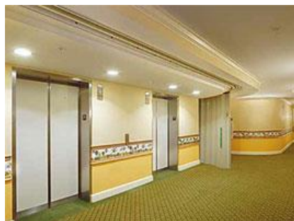
乗客用エレベーター
