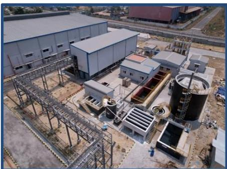
ゼロ液体排出 (ZLD、廃水を外に放出せずに処理する技術) 方式によるプラント
