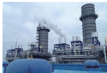
請負事例: 発電所
