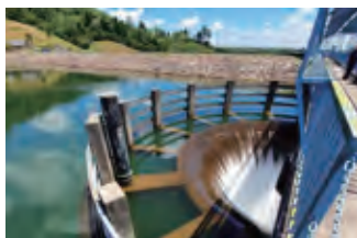
ダム貯水のエネルギーへの変換事業
