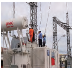
発電所の建設、改修
