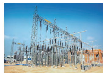
団地内電力施設
