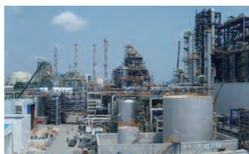
請負事例: 石油化学プラント
