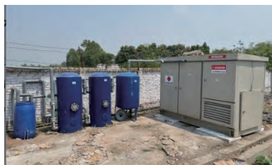
発電機用バイオガス精製機
