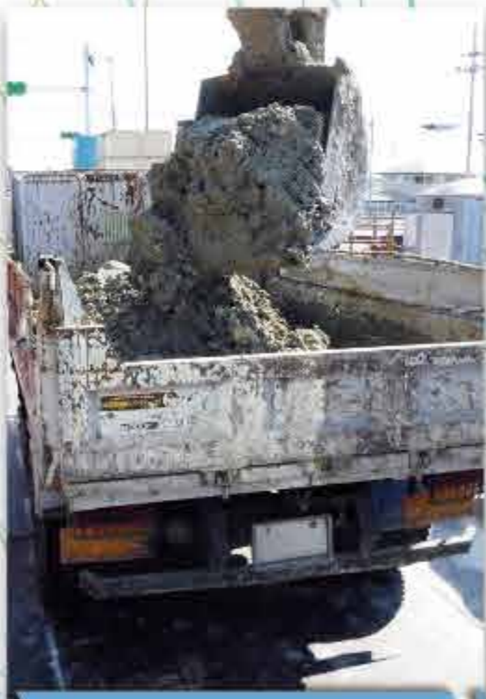
ダンプトラック積込み
