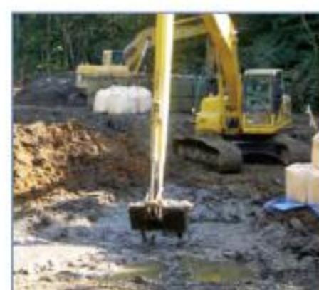
ため池堆積土
