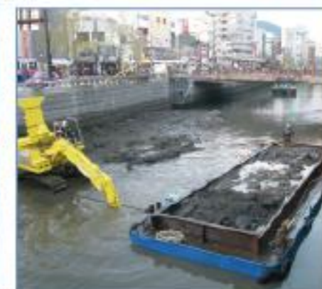
河川・港湾浚渫土
