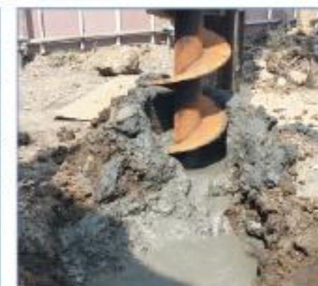
地盤改良・杭打ち泥土
