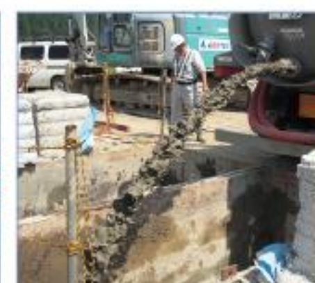
各種建設汚泥
