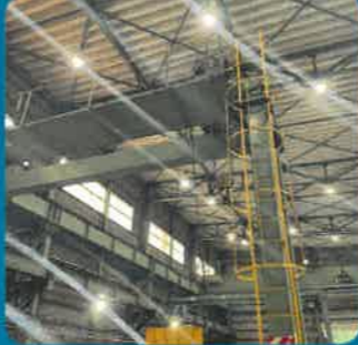
片足クレーン4基
