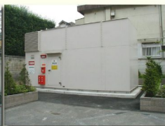
防音シェルター
