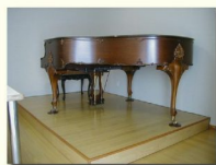
ピアノ無響床 (音響遮断)
