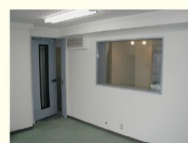
防音スタジオ、防音扉 防音壁軽量遮音工法 (1)
