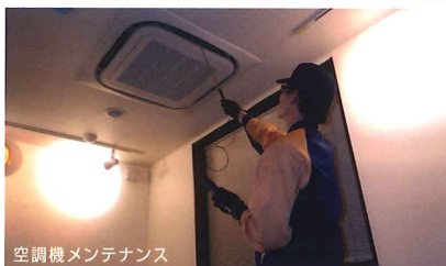
空調機メンテナンス
