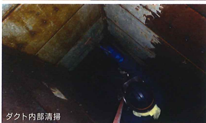
ダクト内部清掃
