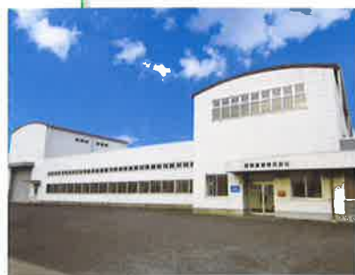
■服部産業株式会社 第二工場 ●配電盤部 〒850-0078 長崎市神ノ島町1丁目367-13
