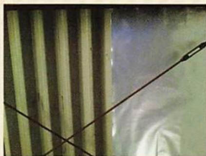
屋根下遮熱 左側なし 右側施工あり
