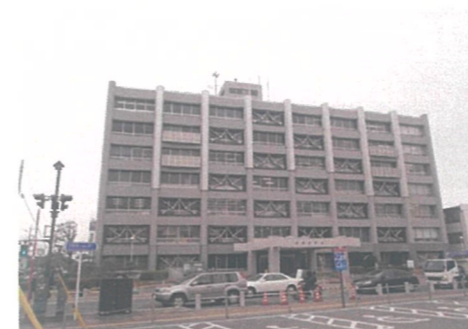
川越市本庁舎耐震改修
