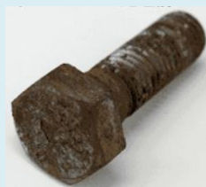
②赤錆が発生したボルト
