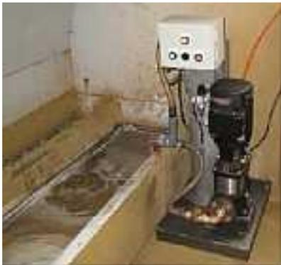
マイクロバブル装置を設置し、強制的にブース水の循環を促す。
