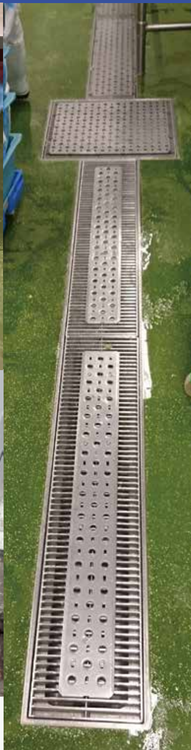
工場の出入口周辺の外構のグレーチングは特に危険なポイントであるため、全面に設置
