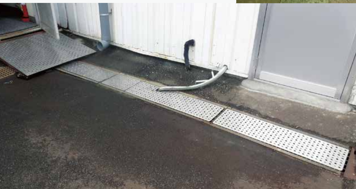
工場の出入口周辺の外構のグレーチングは特に危険なポイントであるため、全面に設置
