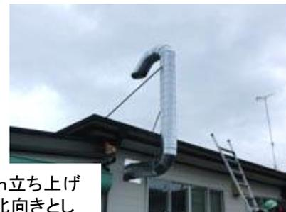
排気ダクトは軒先より1.5m立ち上げ客先と打ち合わせの上、北向きとし45度下向きの吹き出し角度に設定
