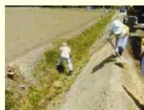
土水路の中に作動油がこぼれたのでオイルゲーターを使用し、早期処理を行い、油分の流出を防いだ。 (作動油7リットル程度にオイルゲーターを4kg程度撒き処理)
