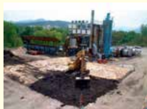
油が含まれた土壌の改良
