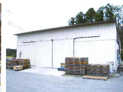
第3工場・倉庫（敷地面積634㎡）
