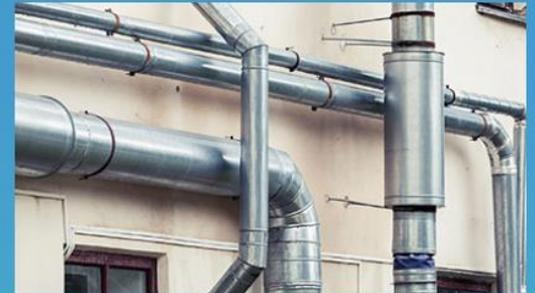
火災時、最も危険と言われる煙を排出するため、ビルやマンションなどの施設に必ず設置されます。消防法や建築基準法によって換気や排煙、風量などの基準値が定められている中で、最も効率的に排気が行える導管配置技術が求められます。また、飲食店の排煙ダクトなどは近隣環境を加味して設置する必要があります。
