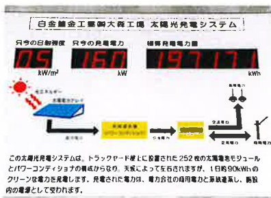
太陽光発電システムの電力表示パネル
