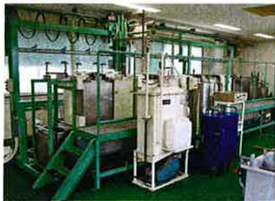
無排水めっき処理システム
