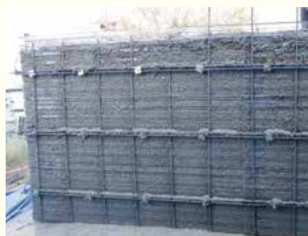
▲生コン注入完了
