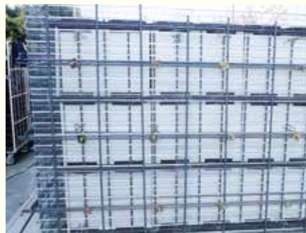
▲外側型枠のラス網をセット
