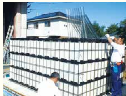
▲アクアパレスの外周面に内側型枠のプラダン(白色の板)と鉄筋をセット
