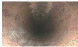
エコイオン導入後の熱交換器内部銅チューブの健全な状態を維持
