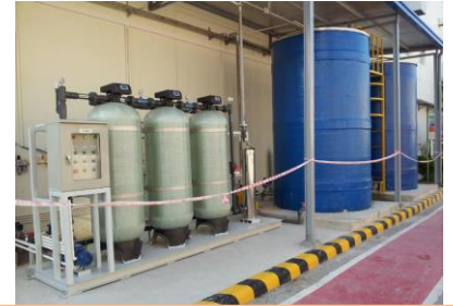
日系工場向け 除鉄・除マンガン処理 6,000L/h
