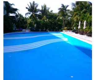
ダナンリゾートホテル向け プール補修工事(タイル→FRP 表面処理)
