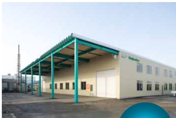
第三工場 大型板金
