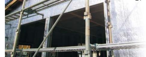
屋根下、壁面をアルミ純度99%、反射率97%の高遮熱材ラミパックSDで覆うことにより、春夏秋冬、不眠不休で働き続け、輻射熱をはね返します。その効果は絶大で、夏の暑さも冬の寒さも遮熱・反射し快適な空間を造ります。
