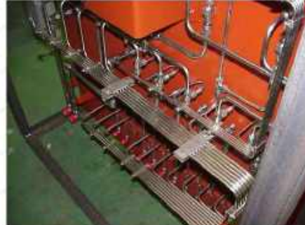
チュービング配管施工計装現場
