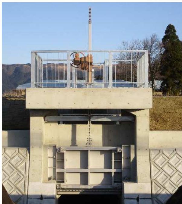
阿蘇地域振興局 阿蘇市黒流町地内 ローラゲート 2.0m × 1.3m 1門 フラップゲート 2.0m × 1.3m 1門
