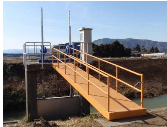
阿蘇地域振興局 阿蘇市跡ヶ瀬 ローラーゲート 扉体交換 2.5m × 2.5m 1門
