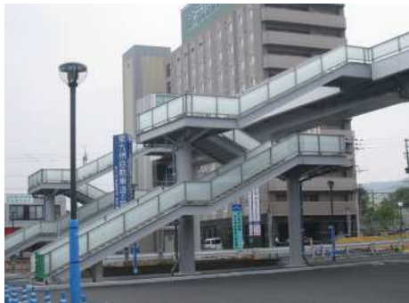
マツモト(株) (福岡県行橋土木事務所) ペDESTリアンデッキ歩道橋 (苅田駅) 階段、踊り場、橋脚 幅員2.5m
