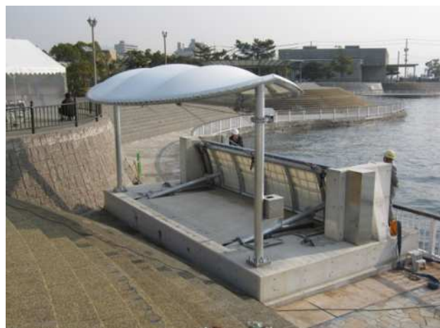
国土交通省 広島県広島市 膜式ラジアルゲート 6.0m × 1.3m
