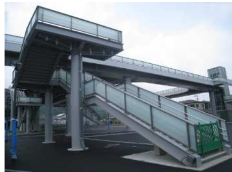
マツモト(株) (福岡県行橋土木事務所) ペDESTリアンデッキ歩道橋 (苅田駅) 階段、踊り場、橋脚 幅員2.5m
