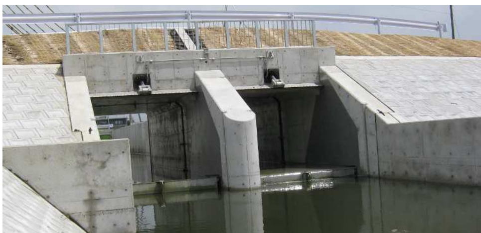
熊本市役所 熊本市秋津町 フローティングゲート 3.2m × 2.6m 異物嚙込防止装置付き
