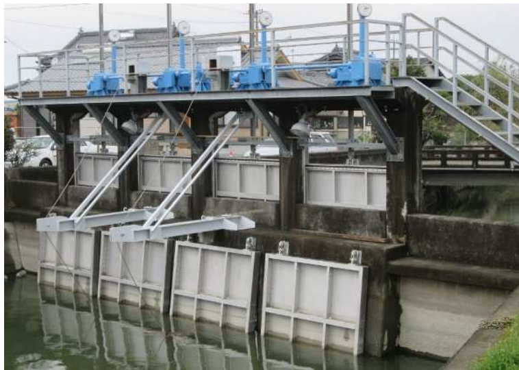
八代地域振興局 八代郡氷川町網道 スライドゲート、フラップゲート 扉体交換 2.0m × 2.0m 各4門
