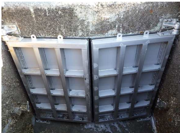
八代地域振興局 八代市大島町 マイタゲート 扉体・下部戸当り・ヒンジ交換 3.0m × 2.5m 2門
