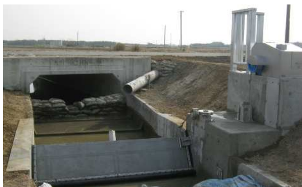
熊本市役所 熊本市秋津町 フローティングゲート 3.2m × 2.6m 異物嚙込防止装置付き
