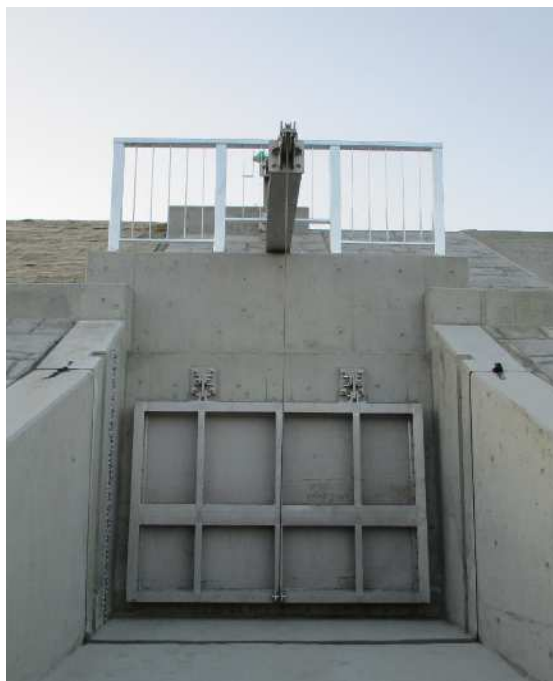
阿蘇地域振興局 阿蘇市黒流町地内 ローラゲート 2.0m × 1.3m 1門 フラップゲート 2.0m × 1.3m 1門
