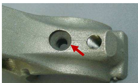
図.2-2 大端(Rod側)油孔(鑄抜き孔)
